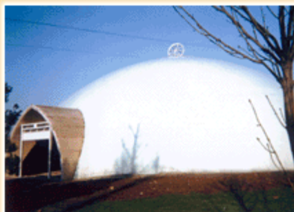
Cobertura del depósito de la estación de decantación - Diámetro 40 m y altura 13,50 m - Houplin - Francia - 1992
