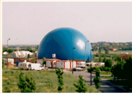
Cité de l'espace Géode hauteur 17 m et diamètre équateur 21 m -Toulouse - France - 2000
