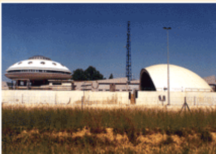
Stockage sel de déneigement Choisey - France - 1998
