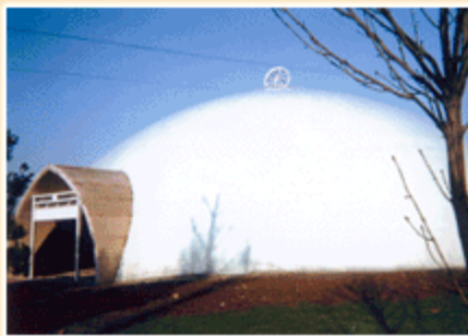
Couverture du bassin de la station d'épuration - Diamètre 40 m et hauteur 13,50 m Houplin - France - 1992
